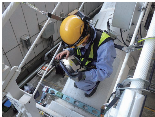
図 4 現場検証 (作業者はケーブルに乗って計測している)
