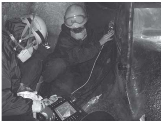
図 9 ステータの検査状況
