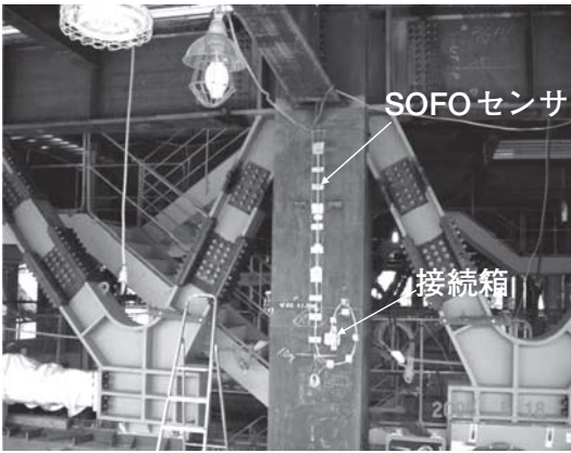
図 8 柱へのSOFOセンサ取付例
