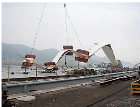
写真6 破壊後の状況
