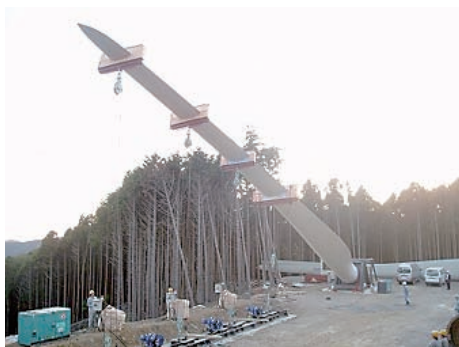
写真4 地上たわみ試験
