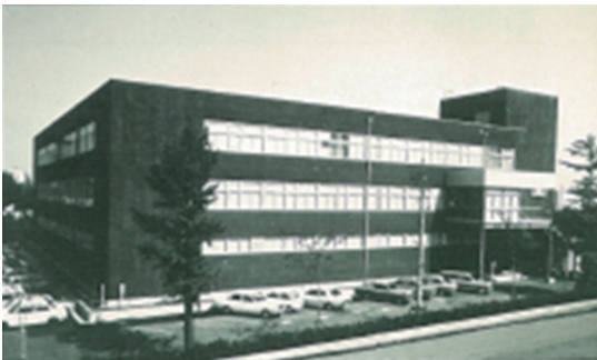
写真3 制御システム技術室/オムニパック
