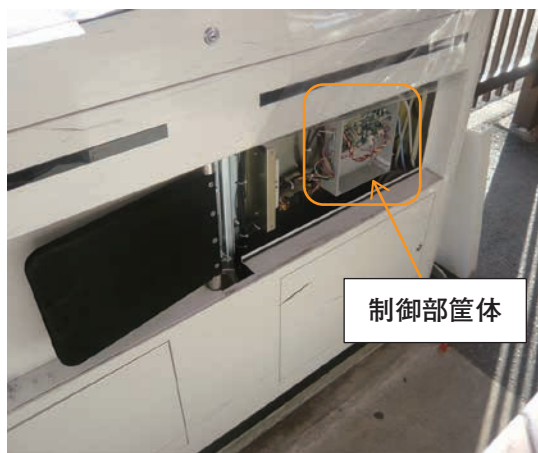
図6 他社機器内に設置された制御部
