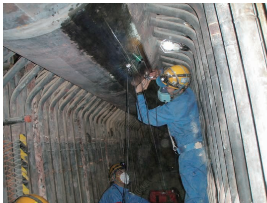
図 2 4号機つり下げ再熱器出口管寄せ長手継手のフェーズドアレイ検査
