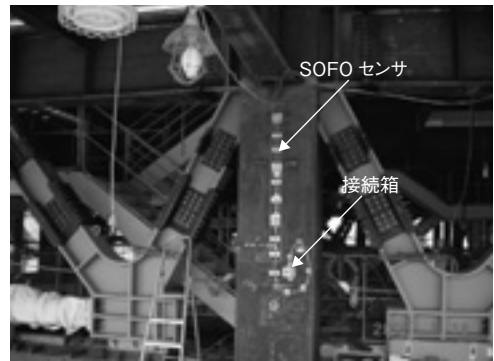
図4 SOFO センサ（柱：X7Y9）
