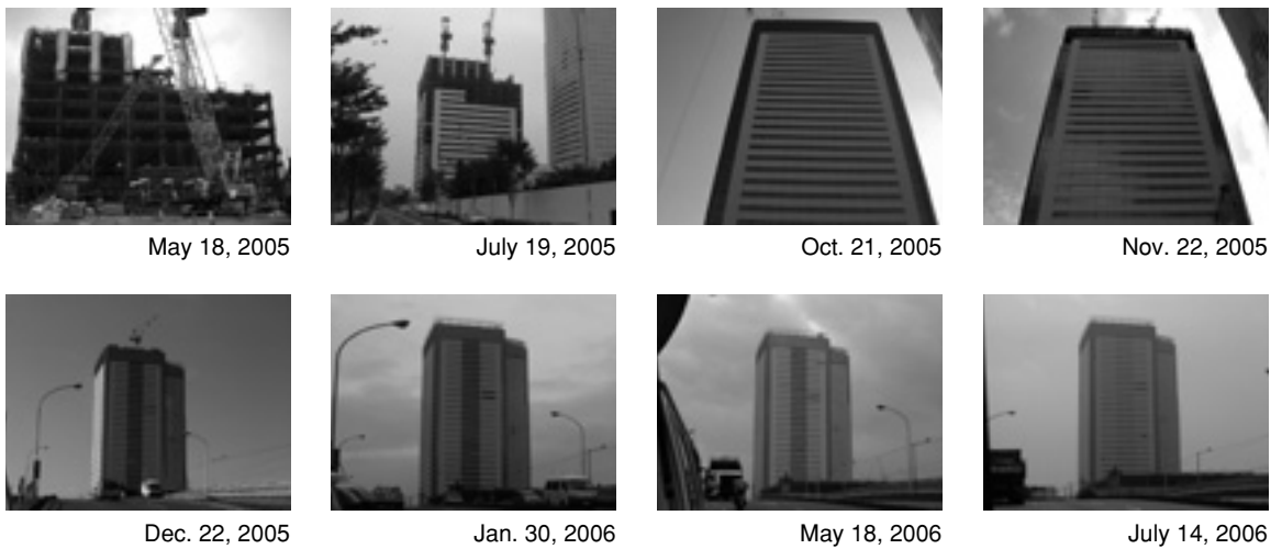
図9 建設中のビルの写真
