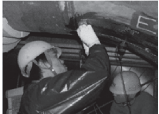
ボイラ耐圧部配管への 超音波 TOFD 法の適用の状況
