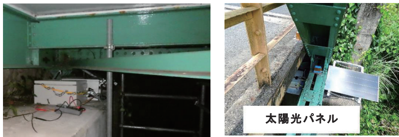
図6 システム設置状況
