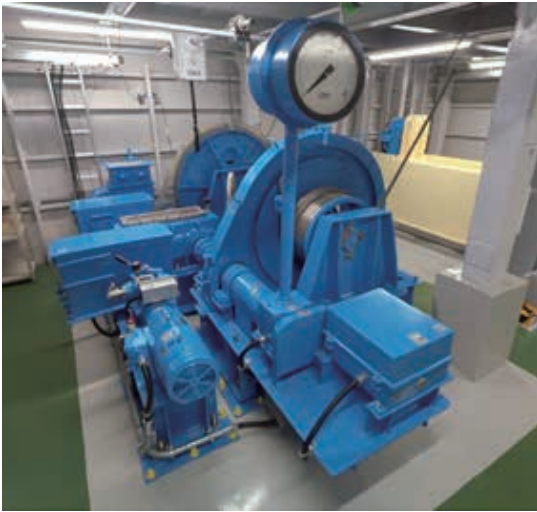
図6 ワイヤロープウインチ式開閉装置
